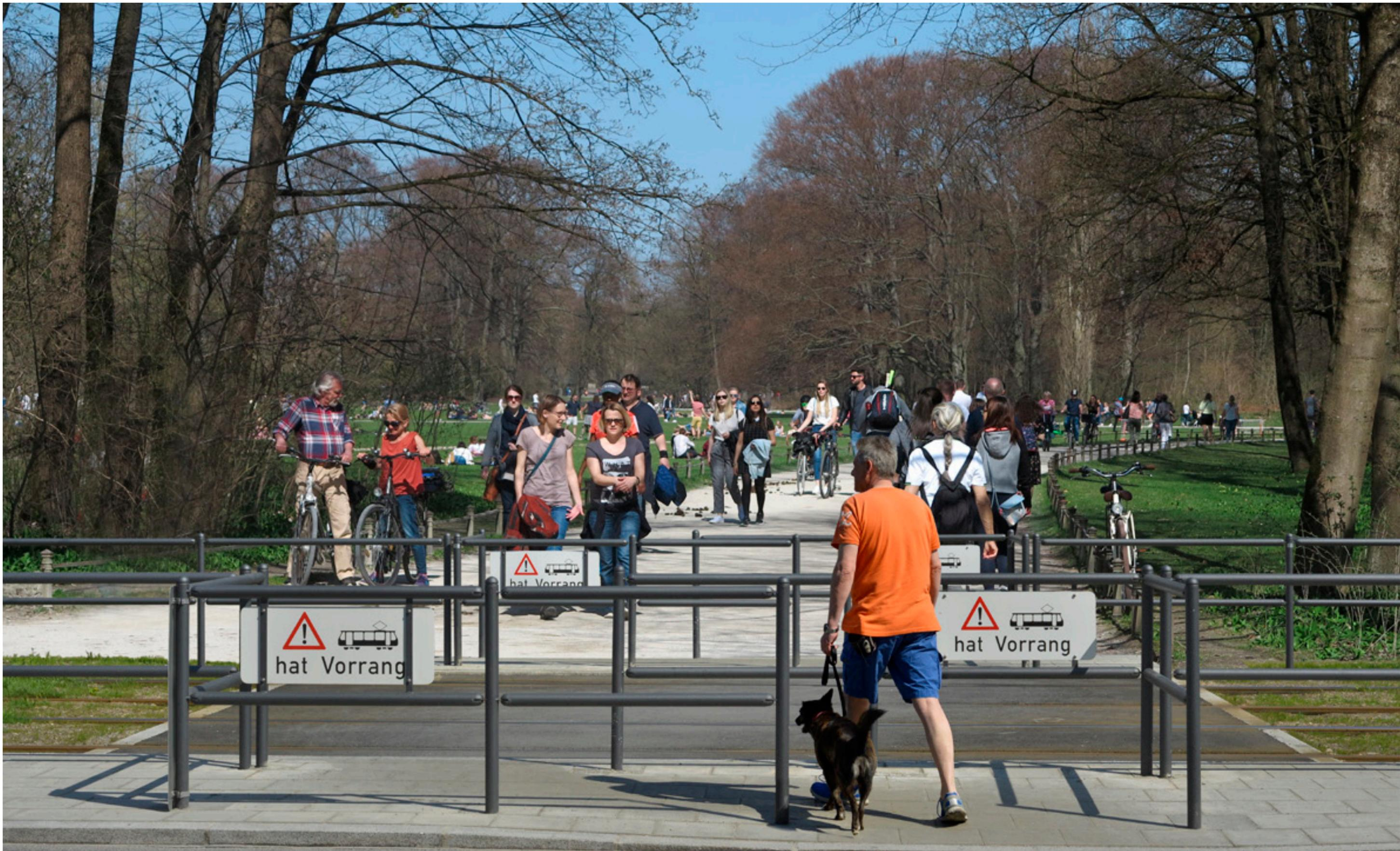
Weil die Tram immer Vorrang hat, müssen zur Sicherheit der Fußgänger an den Übergängen sog. Umlaufsperrn oder Ampeln installiert werden.
