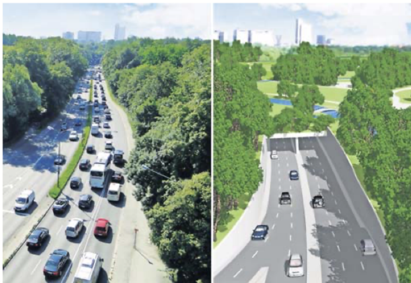
Auf 400 Metern Länge soll die Verkehrsschneise unter der Erde verschwinden. Geplant sind je Richtung zwei Spuren plus Einfädelspur.
