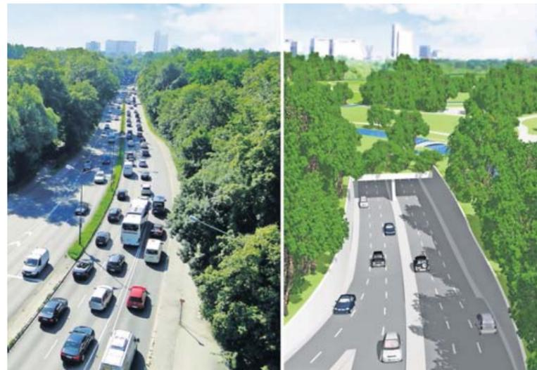
Auf 400 Metern Länge soll die Verkehrsschneise unter der Erde verschwinden. Geplant sind je Richtung zwei Spuren plus Einfädelspur. FOTO: GRUB-LEJEUNE/DPA
