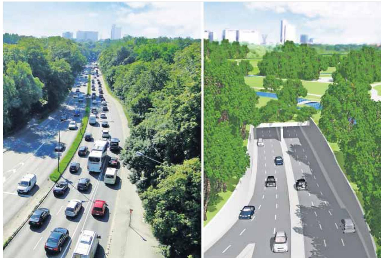
Auf 400 Metern Länge soll die Verkehrsschneise durch den Park unter der Erde verschwinden. Geplant sind je Richtung zwei Spuren plus Einfädelspur. FOTO/SIMULATION: GRUB-LEJEUNE/DPA
